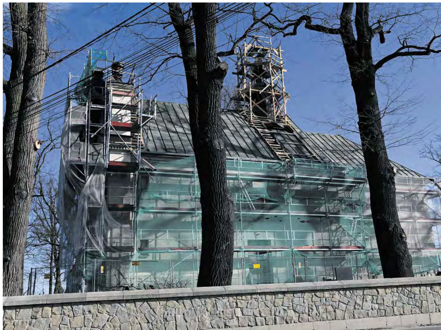
W zakresie renowacji kościoła w Szczepanowie ujęte są między innymi remonty elewacji i dachu.
