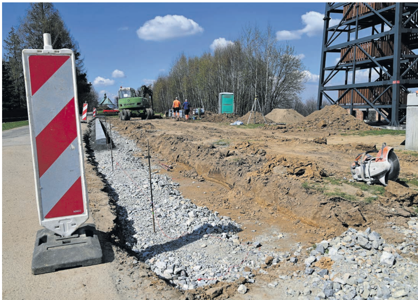
Już niedługo zakończy się budowa zatoki na 10 miejsc postojowych dla samochodów.
