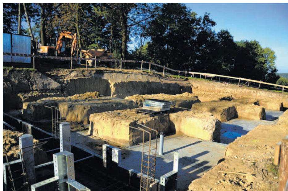
Okocim – plac budowy – 30 września 2024.
