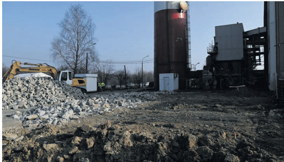
Na terenie brzeskiej spółki prace trwają już od kilku miesięcy.
