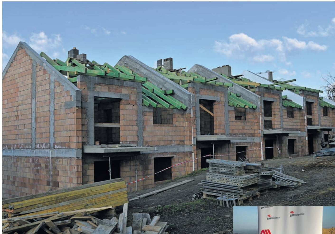
Okocim – plac budowy – 30 marca 2025.
