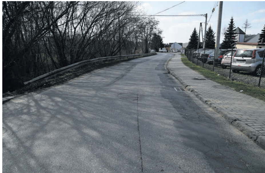
Ulica Pomianowska również sporo „ucierpiała” podczas budowy brzeskiego łącznika – fot. Konrad Wójcik
