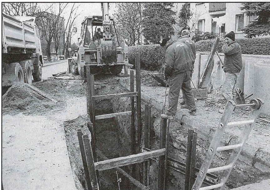
Prace na Ogrodowej
