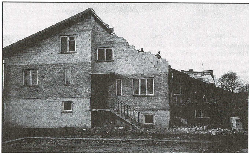
Dach tego budynku wylądował na sąsiedniej działce. Fot. I. Węglowski
