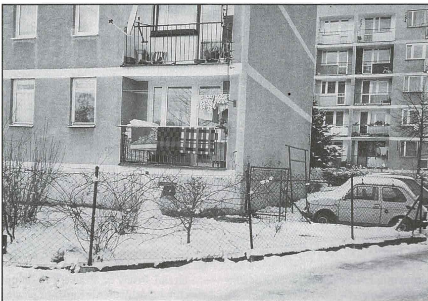
W przypadku pożaru ten blok staje się niedostępny Fot. I. Węglowski
