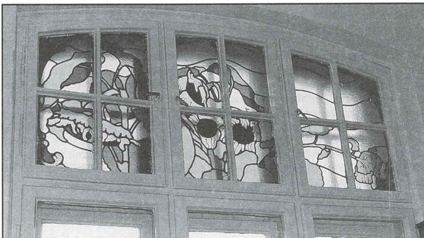
Secesyjny witraż w oknie klatki schodowej
