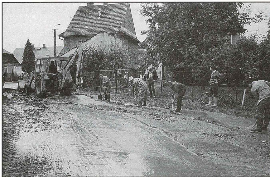
Zniszczona ul. św. Prokopa
