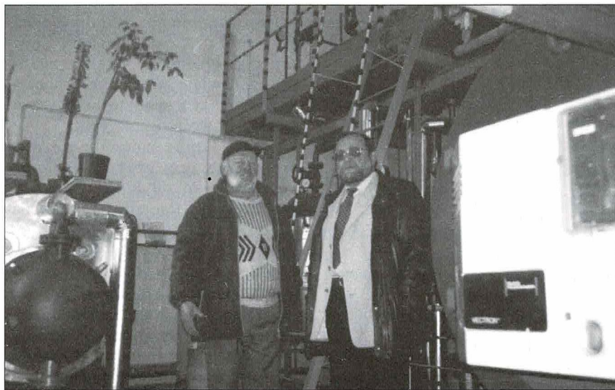
Zmodernizowana kotłownia jest chlubą Dobropaszu
