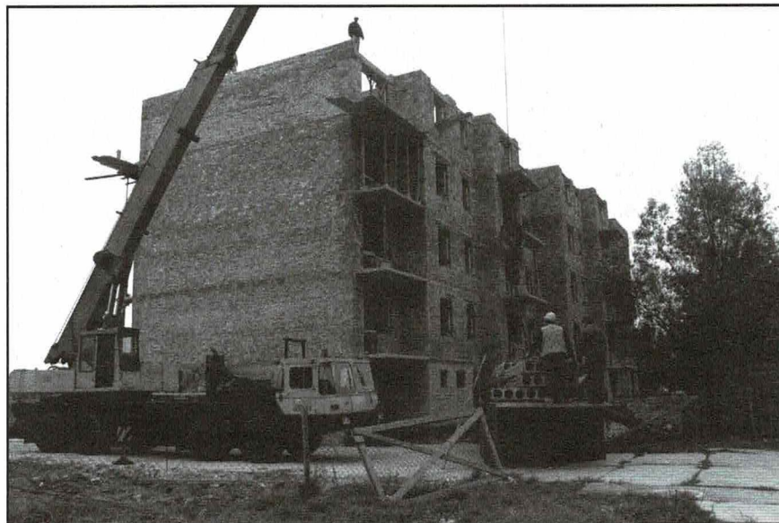
Trwa budowa bloku komunalnego
