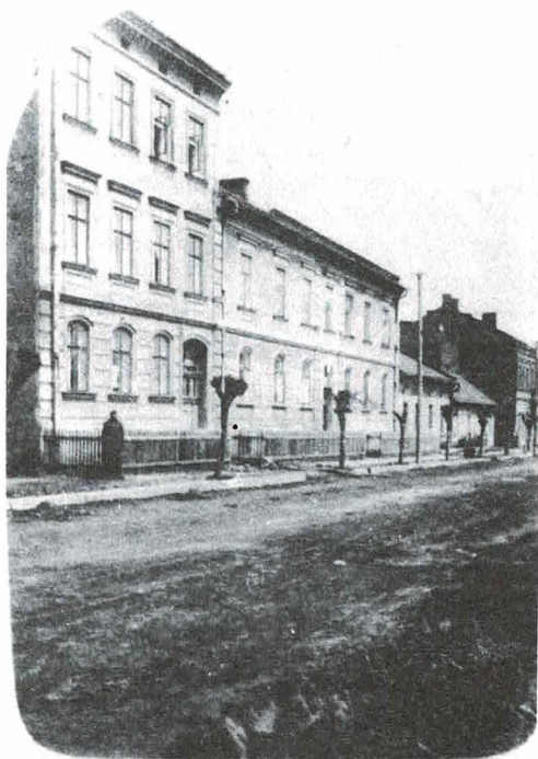
Gimnazjum przy ul. Kościuszki. (dziś szpital) Budynek przed nadbudową II piętra.
