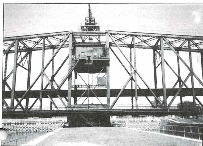
Detal przęśła wahadłowego z widocznymi w głębi wrotami śluz
