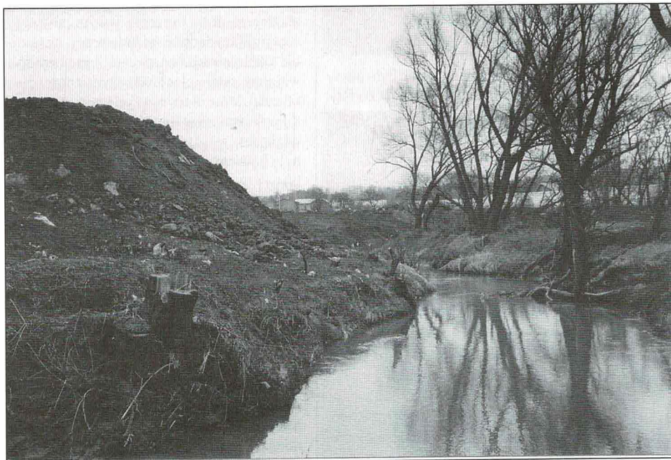
Tworzą prace nad przełożeniem Uszwicy
