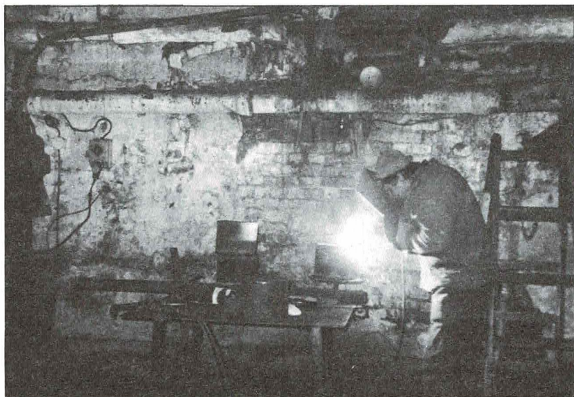
Prace remontowe w ZSME.
