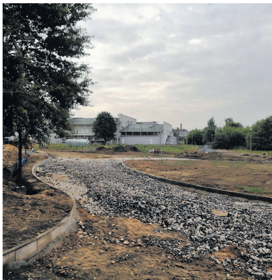
Dzięki środkom z PROW mogła ruszyć w 2019 roku budowa Gminnego Parku Wypoczynku i Rekreacji, fot. P. Miś-Wiewióra
