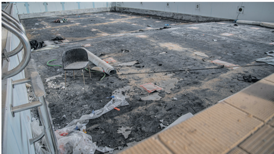
Niecka basenowa w trakcie i po generalnym remoncie
