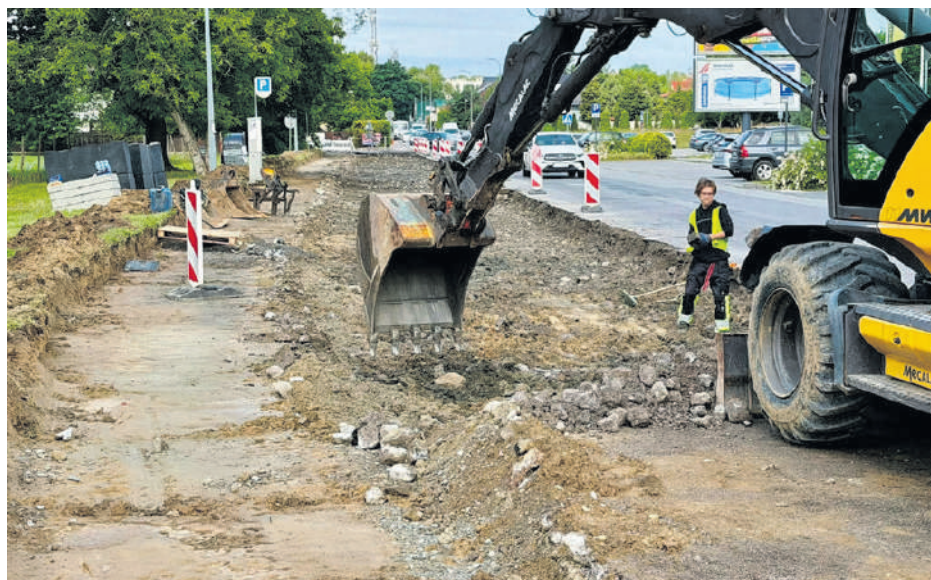
Przy ul. Powstańców Warszawy przebudowano również parking
